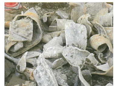
<横浜市神奈川区／H鋼の撤去>
