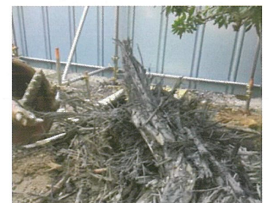
<東京都中央区／松杭の撤去>
